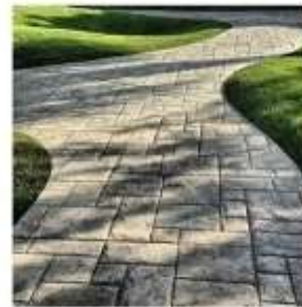
Край плитки на раствор
