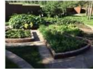
Огород из тротуарной плитки 100*200 в 4 ряда Основание - отсыпка галькой (цвет плитки - исходя какой цвет мощения будет)
